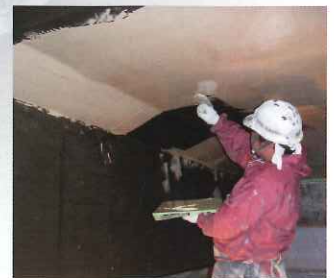
中塗り施工状況 タフガードQ-Rこて塗り
